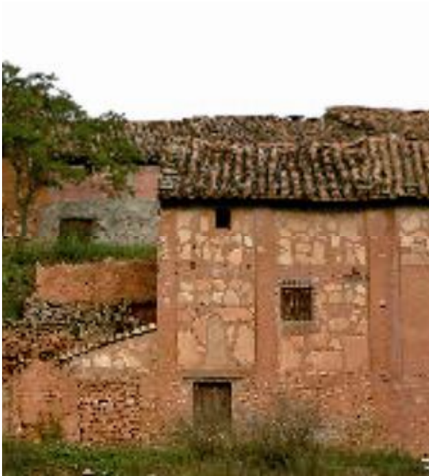
Maison construite avec des piliers en plâtre comme seule armature © Vegas & Mileto
